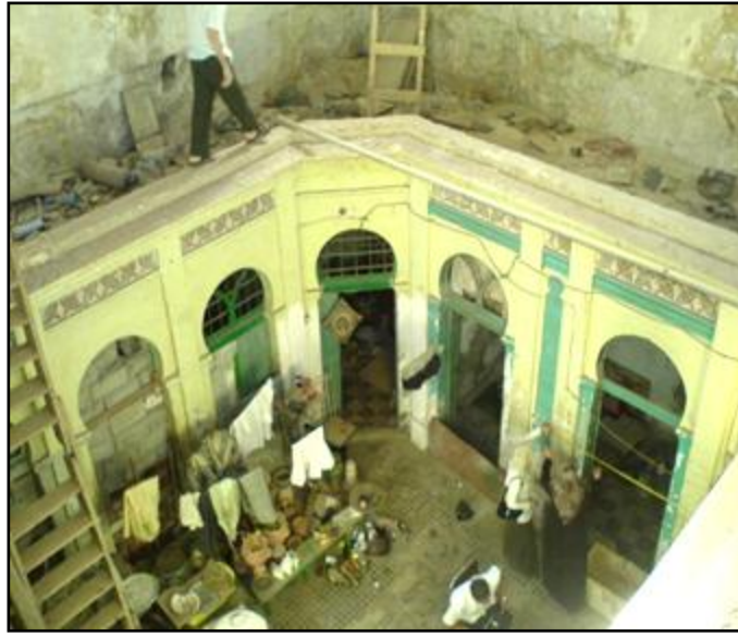
صورة ( 6 ) سقف غرف الحجرة الباردة بالحمام ( تصوير الباحثة )
