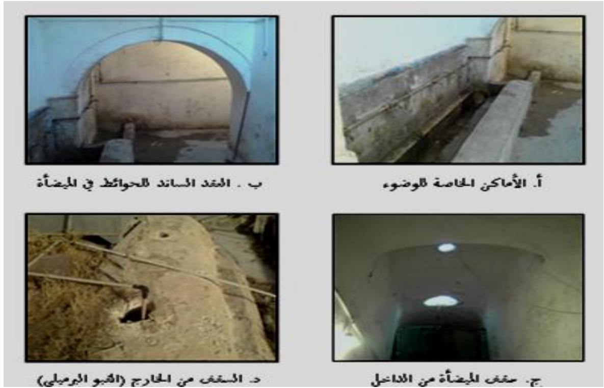
صورة (11) الميضأة الملحقة بالحمام
