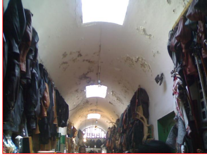
صورة(10) توضح فتحات الإنارة الموجودة بسقف سوق الصناعات التقليدية بالمدينة القديمة -طرابلس الغرب (تصوير الباحثة، دراسة ميدانية بتاريخ 2007/7/15م)
