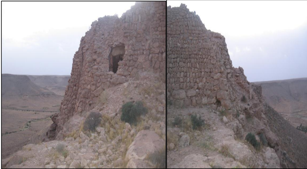
قصر إتلثيين من الجهة اليمنى (الصورة رقم 5) قصر إتلثيين من الجهة اليسرى (الصورة رقم 6) (تصوير الباحث)
