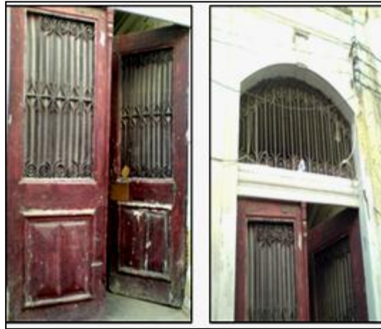
صورة ( 1 ) مدخل الحمام الكبير ( 1649 – 1672م ) ( تصوير الباحثة )
