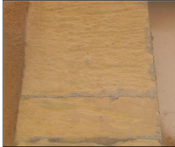
شكل (16) يوضح أثر التجوية الفيزيائية على جدار أحد المباني وهي التجوية المعتمدة على تركيبة الصخر الأصلي (تصوير الباحث).
