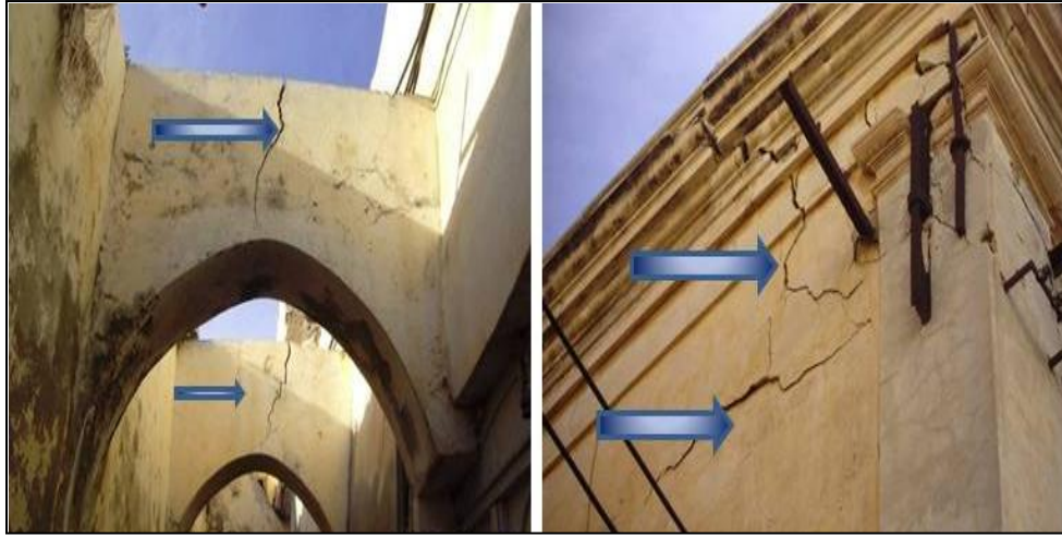
شكل (32) أثر التجوية الفيزيائية على واجهة أحد المباني من الأعلى، وبعض من الأقواس داخل المدينة القديمة بطرابلس، وهي تجوية الشقوق الغير مرتبطة بينى الصخر (تصوير الباحث).
